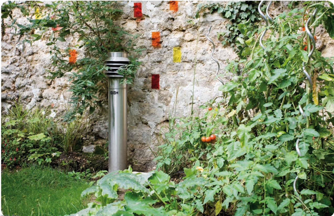
Figure 13.12 La borne de prise d'air du puits canadien est esthétique, inoxydable et équipée d'un filtre à poche très efficace pour isoler l'intérieur de la maison de la pollution (© P. Kozłowski)
