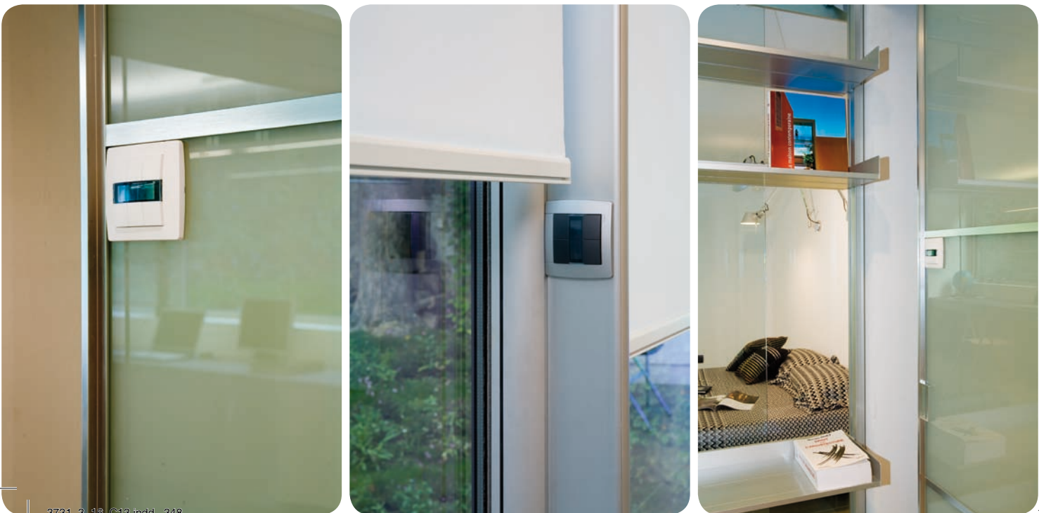
Figure 13.20 Commandes sans fil collées sur les parois ne permettant pas le moindre câblage (© P. Kozłowski)
