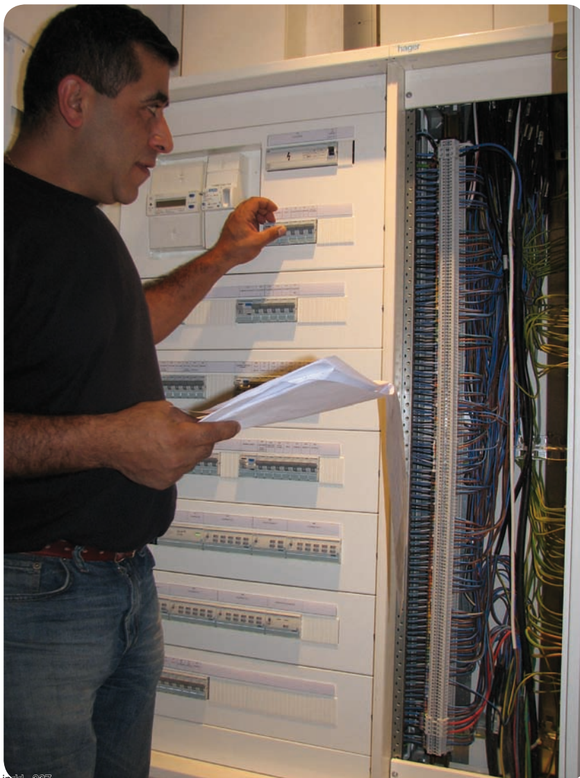
Figure 13.6 L'électricien Ramzi Nammour devant le tableau électrique principal situé au rez-de-chaussée de la maison. On distingue l'arrivée des circuits issus des étages, le raccordement sur bornier facilitant le câblage des modules domotiques (source Ghassan G. Nammour)
