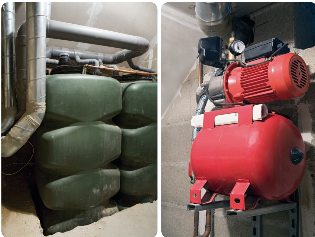
Figure 13.14 Cuves de récupération d'eau de pluie et pompe alimentant les chasses d'eau et l'arrosage du jardin (© P. Kozłowski)
