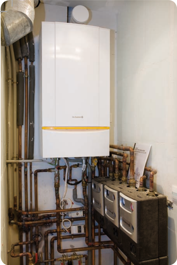
Figure 13.9 Chaudière à condensation (© P. Kozlowski)
