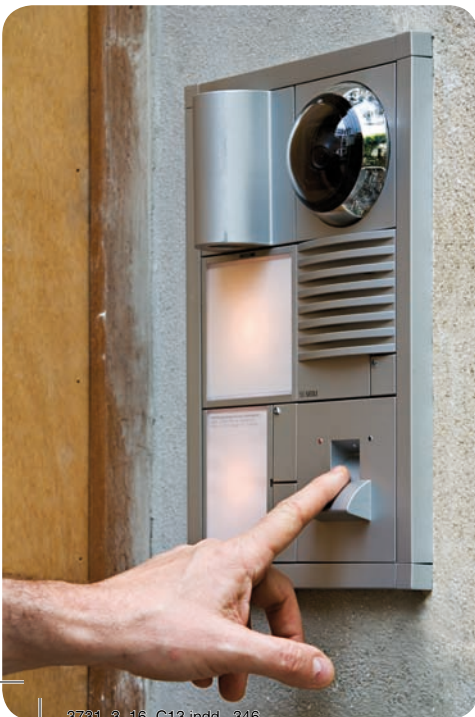
Figure 13.18 Système d'accueil des visiteurs. La platine de rue est encadrée en façade et est constituée d'un bouton-poussoir, d'un micro, d'un haut-parleur, d'une caméra couleur orientable et d'un lecteur d'empreintes digitales capable de gérer jusqu'à cent utilisateurs. Le poste intérieur de la cuisine se compose d'un combiné fixe, d'une sonnerie, de boutons de commande et d'un moniteur vidéo couleur. À droite, le poste audio du deuxième étage (© P. Kozłowski)
