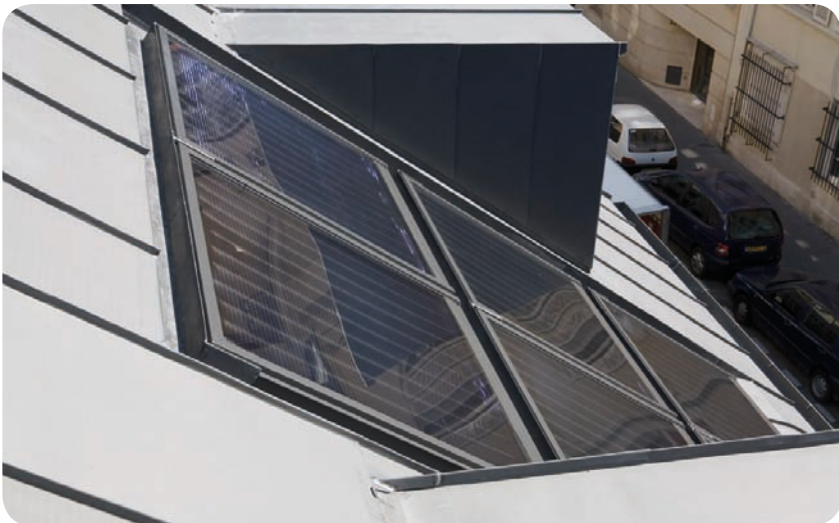
Figure 13.10 Capteurs solaires posés sur le toit de la maison. Leur ressemblance avec des fenêtres de toit a facilité l'obtention des autorisations administratives (© P. Kozlowski)
